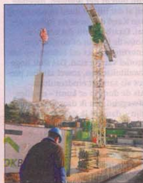
Bouw appartementen, aan de Graafseweg, vlak bij de Wolfskuilseweg.
