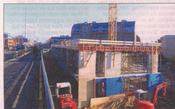
Tussen de Graafseweg en de nieuwbouw op het voormalige Dobbelmanterrein verrijst de 15 verdiepingen hoge Castellatoren met 60 appartementen.
