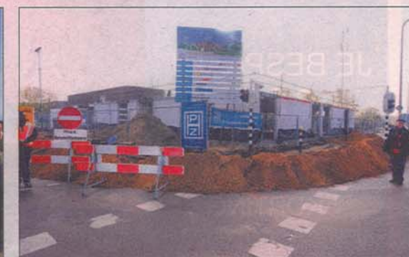
Aan de Tarweg, op de hoek met de Nieuwe Dukenburgseweg, wordt gebouwd aan een Domushuis voor ruim twintig daklozen met een verslaving.
