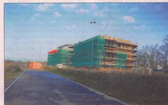
De nieuwbouw van het Citadelcollege aan de Griftdijk (rechts) in Lent vordert gestaag. In augustus gaat deze school voor 1.000 leerlingen open.
