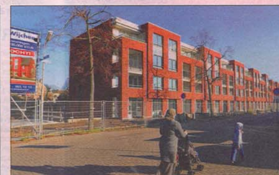
Nieuwe appartementen aan de Sperwerstraat in Nijmegen-West voor 26 dementie ouderen en 230 studenten. Hier stonden tot voor kort bedrijven.
